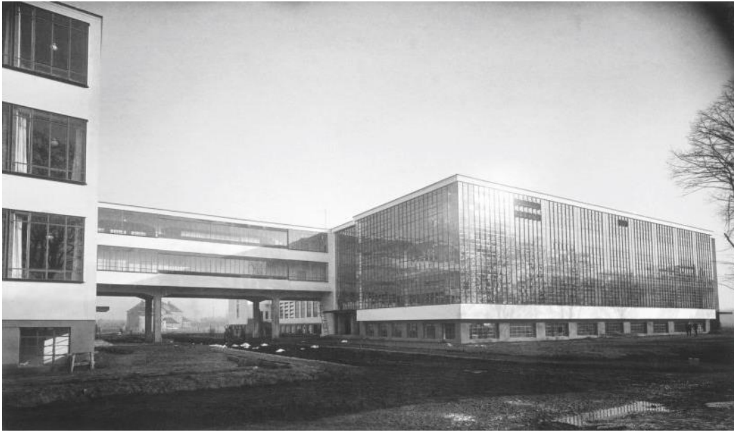
Abb. 3: Bauhausgebäude in Dessau 29
